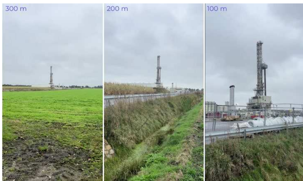
Figur 4-2 Boreriggen set fra henholdsvis 300 m, 200 m og 100 m afstand fra projektområdet
