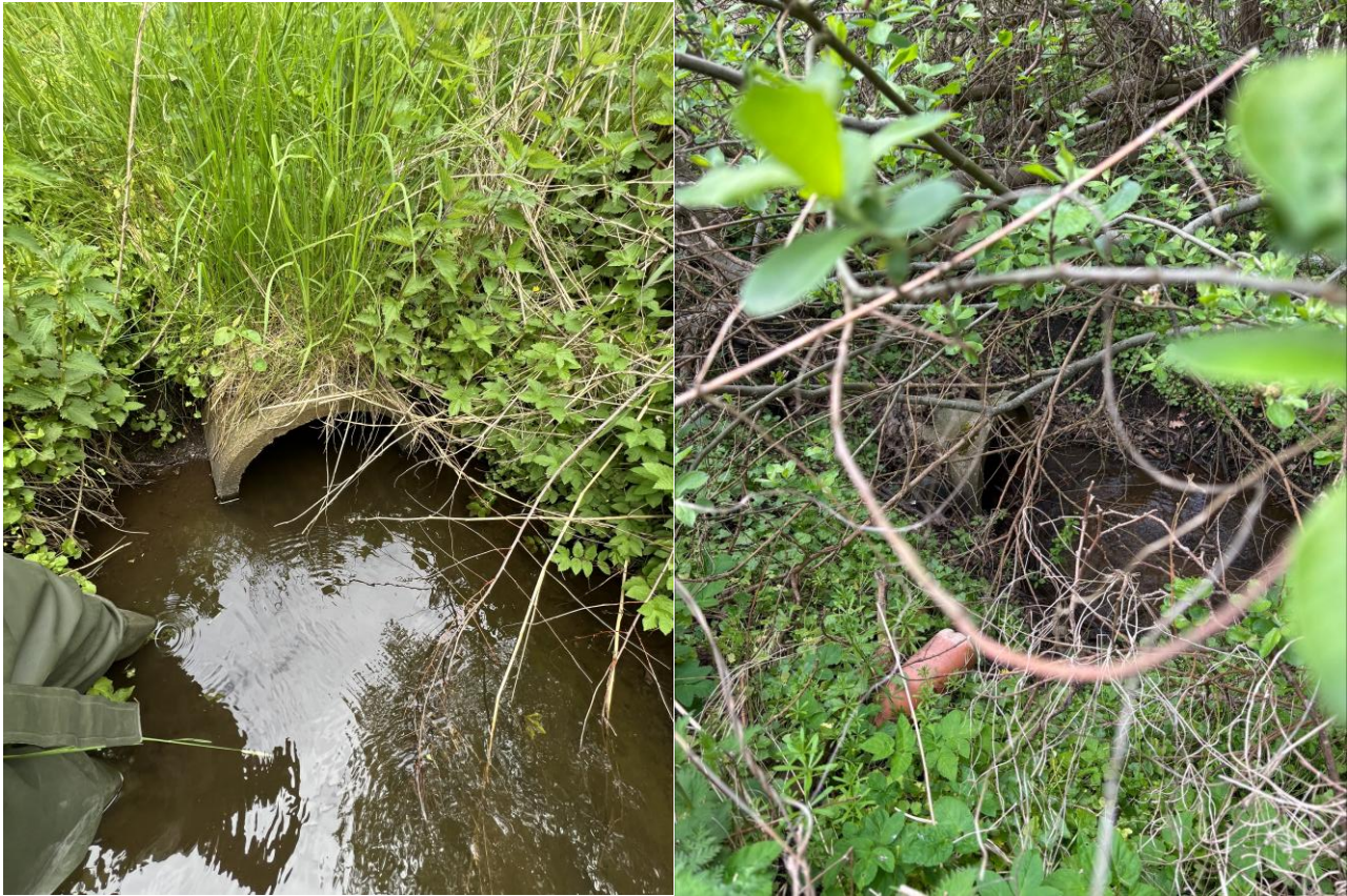
Figur 0.8: Underføring privat overkørsel mod fjorden, Vestre Afløbsgrøft stationering 1920.
