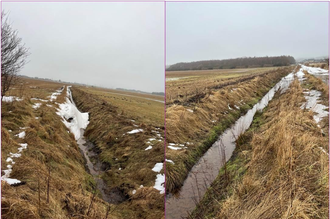
Figur 3.3: Billeder taget af grøfter ved byggemodningsområdet. (Tv. privat vandløb der løber gennem byggemodningsområdet) (Th. vandløb der løber øst for byggemodningsområdet).
