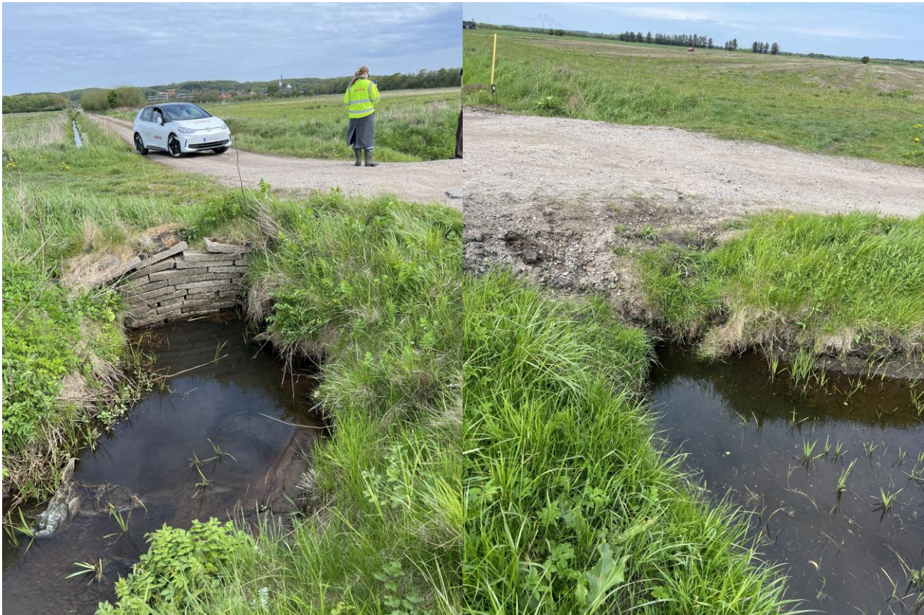
Figur 0.3: Underføring Langbrokrovej. Vestre Afløbsgrøft stationering 604
