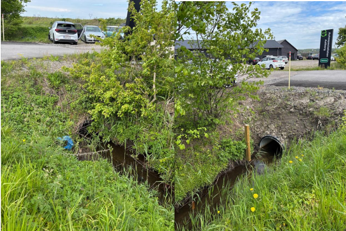
Figur 0.4: Underføring ved Loftbrovej 70, Vestre Afløbsgrøft stationering 1059.
