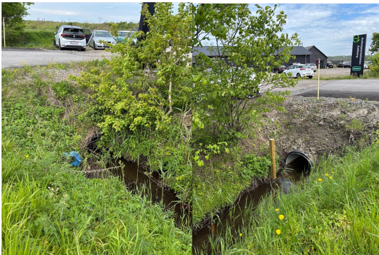
Figur 6.4: Underføring ved Loftbrovej 70 (Opstrøms tv og nedstrøms (th)), billede taget d 18/5-2026.
