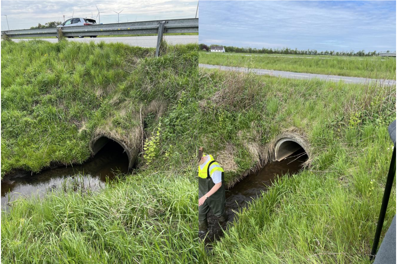
Figur 0.5: Underføring ved Loftbrovej, Vestre Afløbsgrøft stationering 1470
