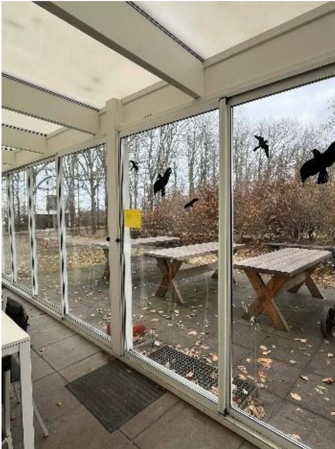
Udgang fra udestue til terrasse
