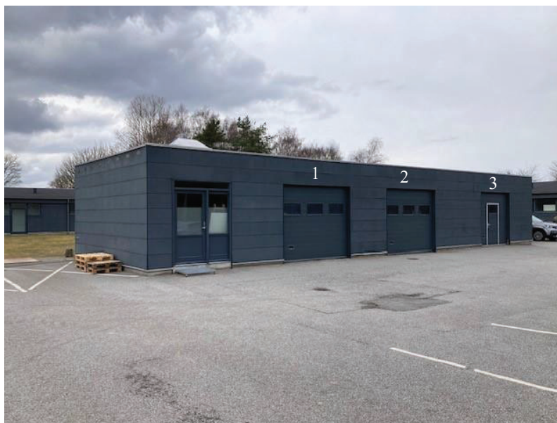
Foto 6: Fritliggende garageanlæg, som indrettes til nye depotrum i port 2 & 3. Der opsættes i alt 28 tråd bure på 0,90 x 1,2 meter.
