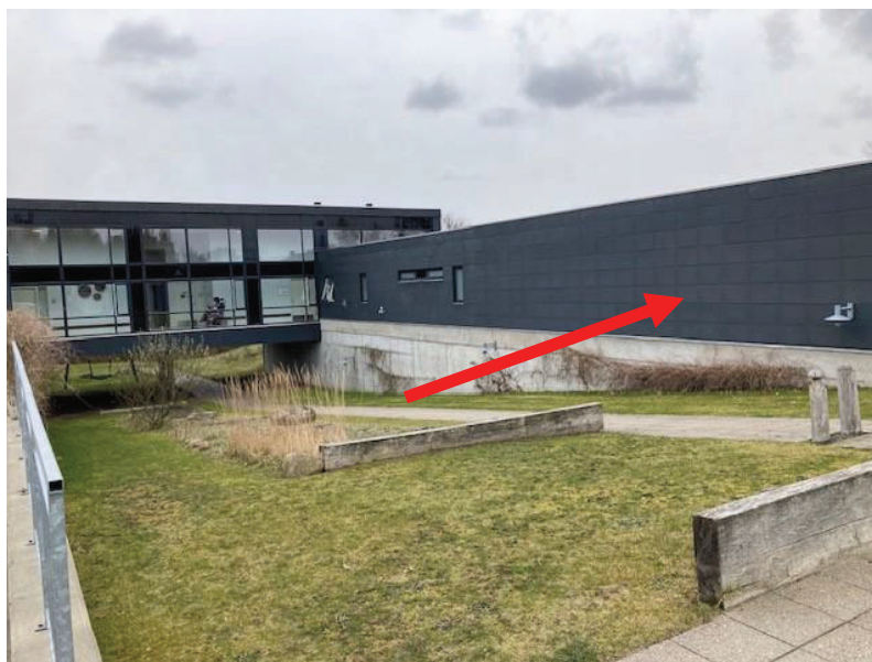
Foto 2: Front på bygning, som ændres fra depotrum til opholdsrum.
