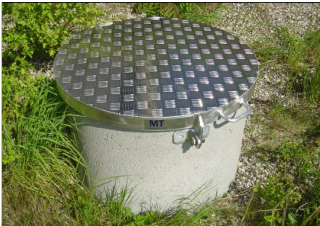
Figur 3 Eksempel på boringsafslutning som vil blive anvendt ved alle 3 boringer.
