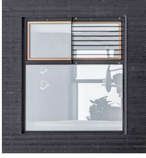
SORTE VINDUESRAMMER, GYLDEN V. GÅENDE PARTI
