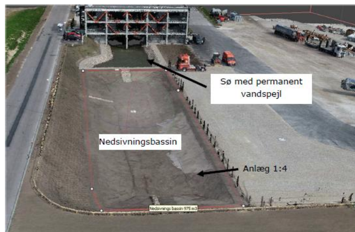
Figur 3: Udformet nedsivningsbassin. Billedet angiver placering af permanent sø ved siden af nedsivningsbassin på Brøndborerens Alle, Svenstrup.
