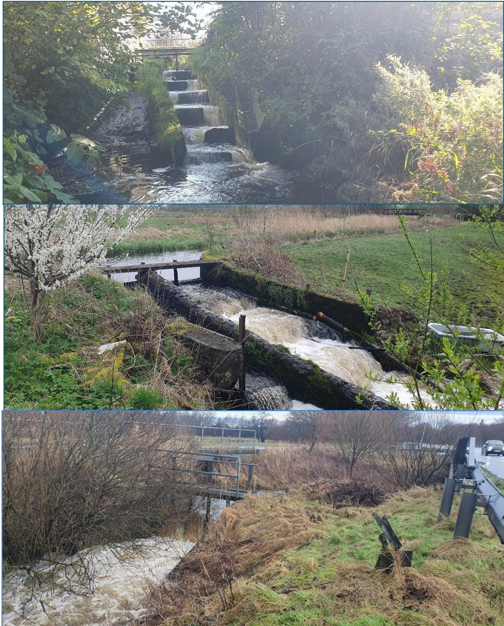
Fig 35. De tre opstemninger/omløb i Binderup Å ved Binderup Mølle. Øverst ; opstemning ved fisketrappen Aalborgvej 99, midt ; opstemning ved fisketrappen syd for Ny Nibevej. Nederst ; opstemning ved reguleringsbygværk mellem Gl. Aalborgvej/Ny Nibevej.
