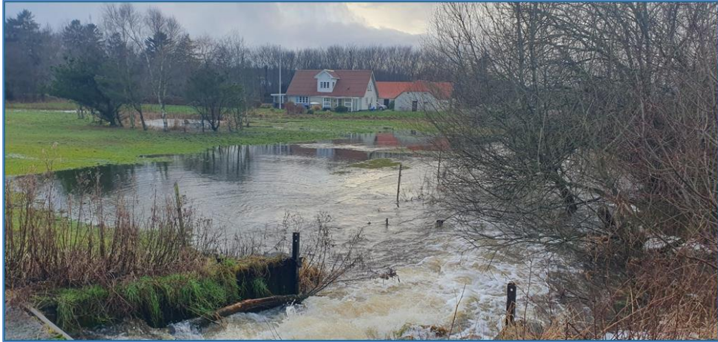
Fig 20. Under de nuværende forhold ses ved store afstrømninger i oplandet oversvømmede lave arealer ved den sydlige fisketrappe, som følge af vandstuvning. Et eventuelt dæmningsbrud vil forværre oversvømmelserne drastisk, idet vejunderføringen under Ny Nibevej på dette sted er underdimensioneret og ikke kan tage hele vandmængden i Binderup Å.
