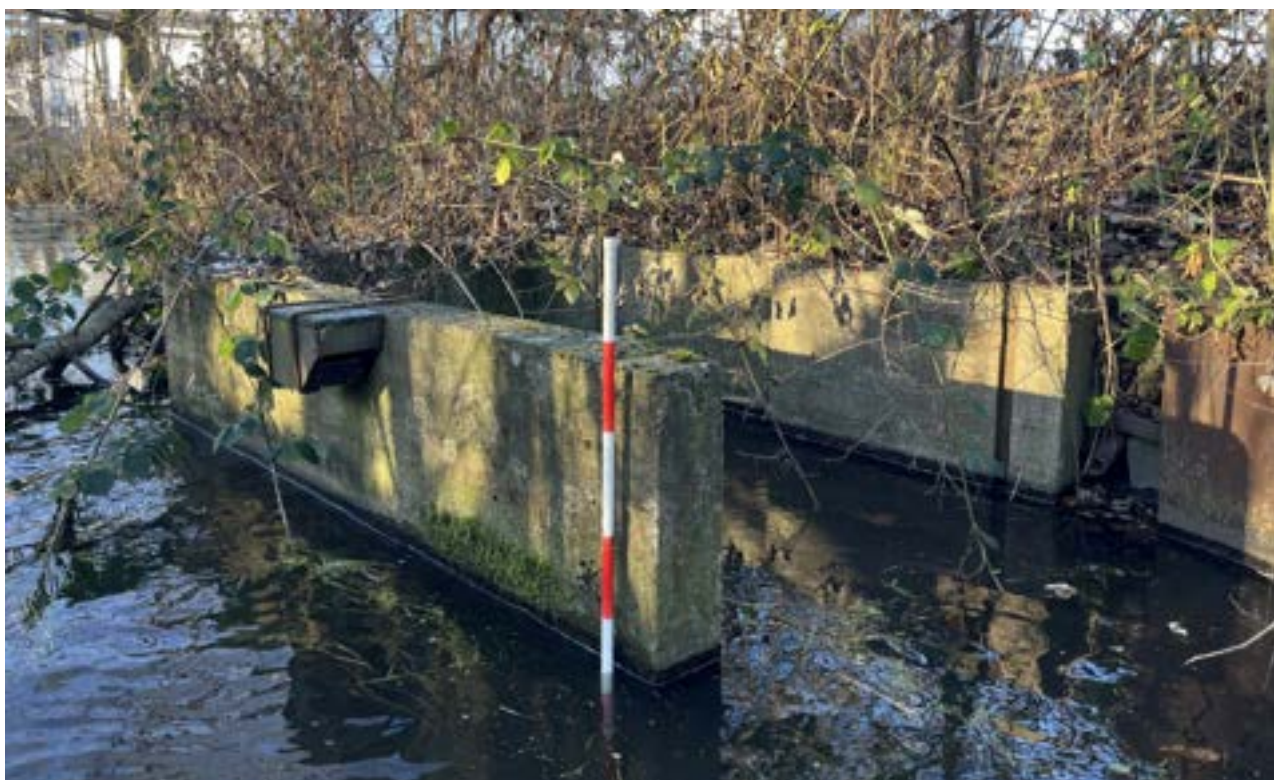
Figur 1C Bygværk som fjernes ifm. restaurering.
