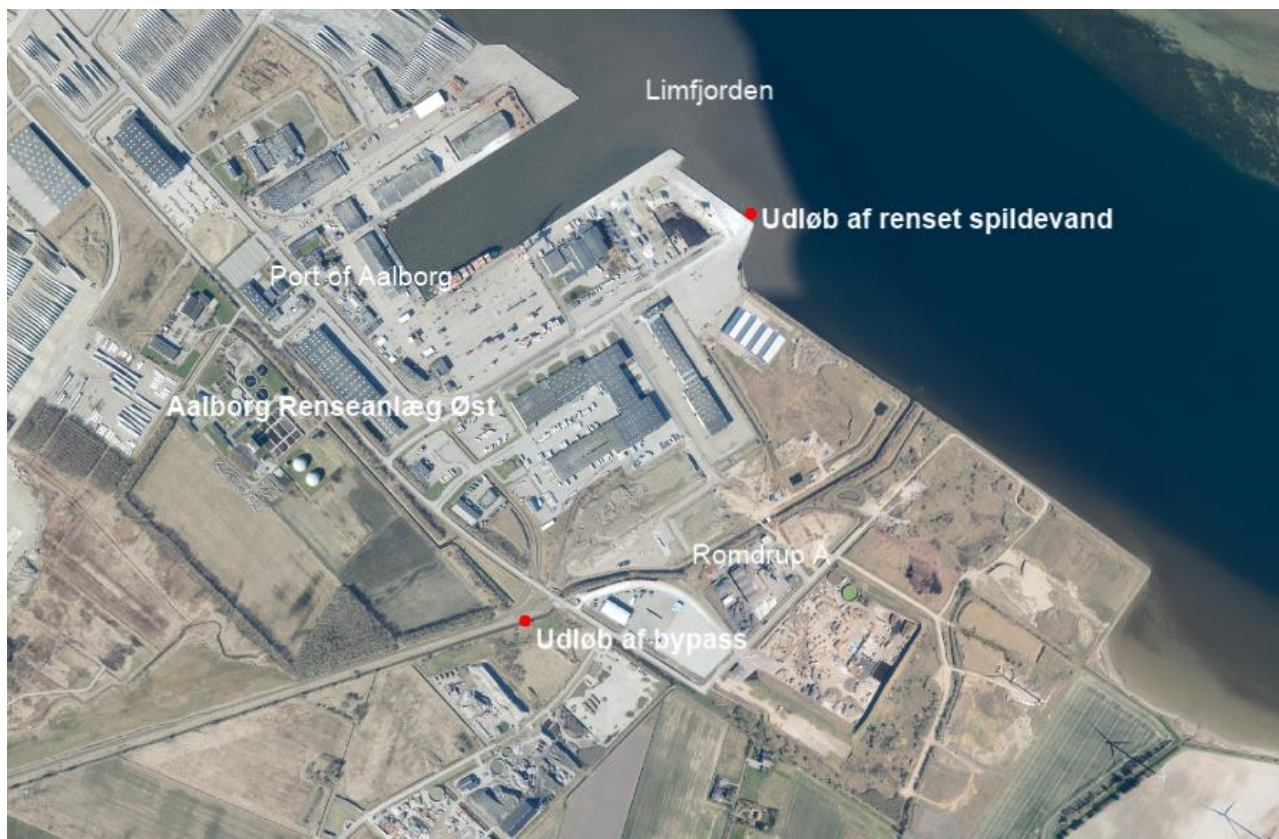
Figur 1: Placering af Aalborg Renseanlæg Øst i Aalborg Øst ved Port of Aalborg, rensanlæggets udløb i Limfjorden og udløb af bypass til Romdrup Å.
